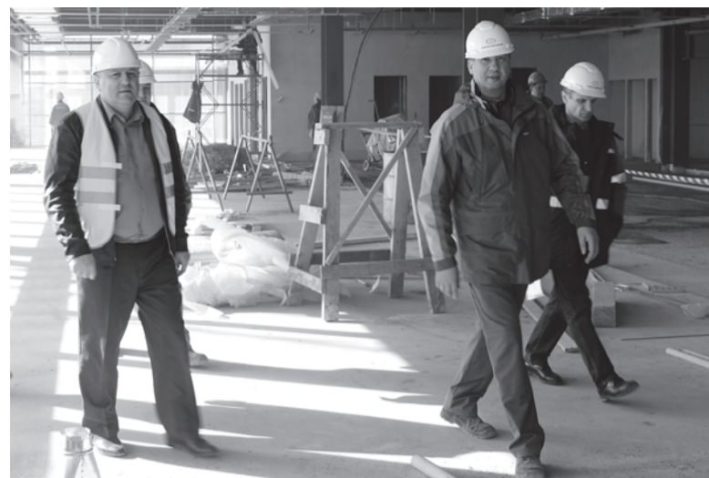
Осмотр в строящемся терминале
